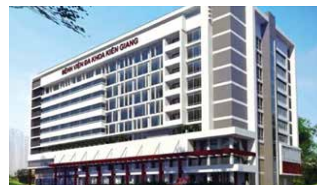
Bệnh viện Đa khoa Kiên Giang (đang thi công)
