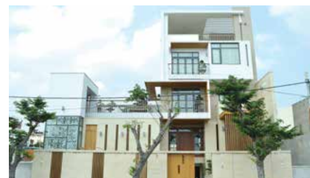
Biệt thự Lô 36, 37, 38, 39 Khu TĐC Viện Cổ Chàm Đường 2.9, TP. Đà Nẵng
