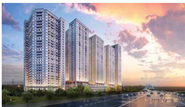
Khu đô thị Eurowindow River Park (Đang thi công), Đông Hội, TP. Hà Nội
