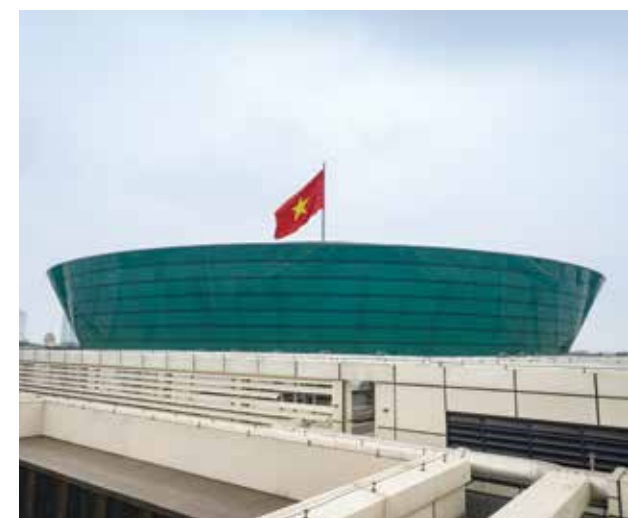
Mái che (Skylight) của Eurowindow tại công trình Nhà Quốc Hội, Q. Ba Đình, TP. Hà Nội
